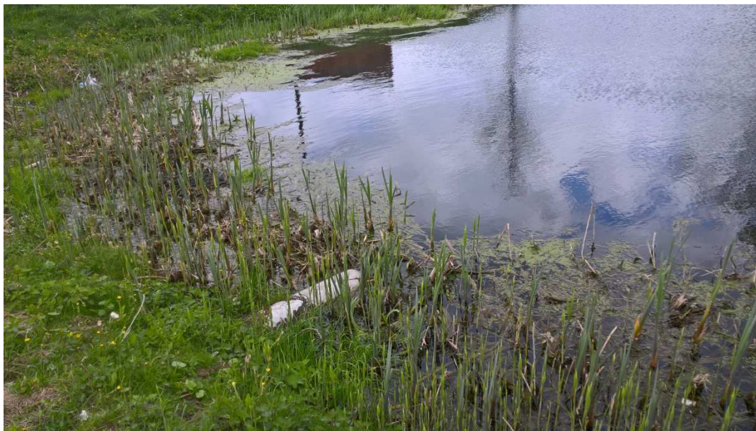
Fot. 6. Rurociąg wylotowy ze stawu nr 2 do stawu nr 1 – odpływ zapewniony, rurociąg do remontu
