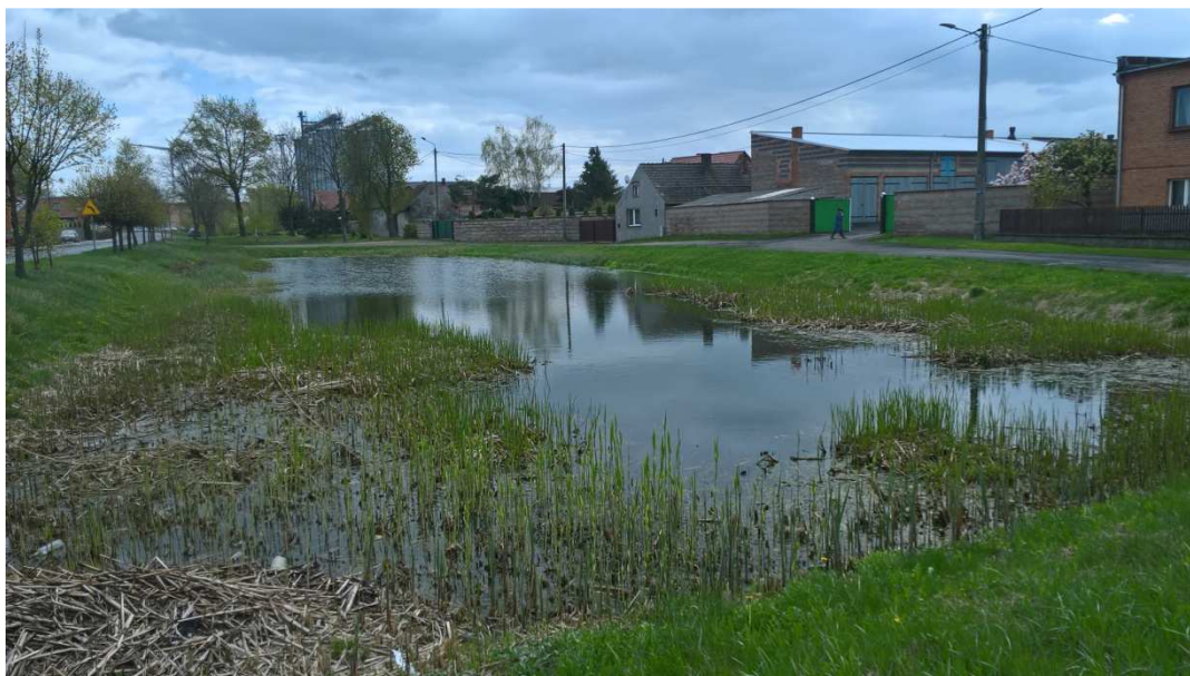
Fot. 2. Widok ogólny zbiornika od strony zachodniej – widoczne dość znaczne zamulenie dna
