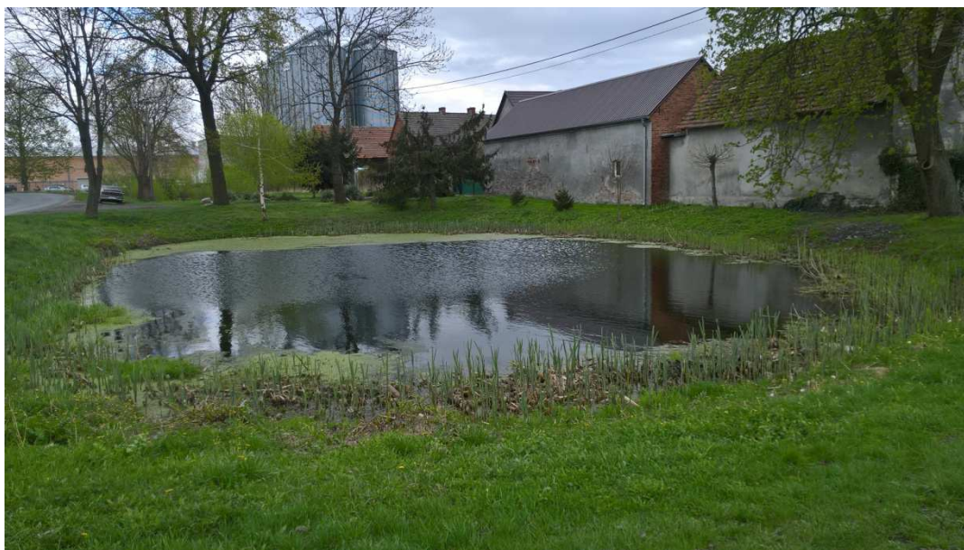
Fot. 5. Widok ogólny zbiornika od strony zachodniej – widoczne znaczne zamulenie dna przy skarpach
