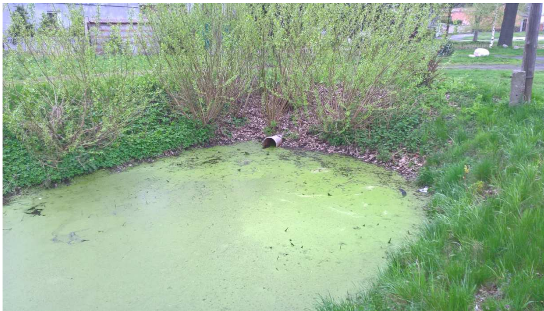
Fot. 9. Rurociąg wylotowy ze stawu nr 3 do stawu nr 2 – odpływ zapewniony, ruropciąg do remontu
