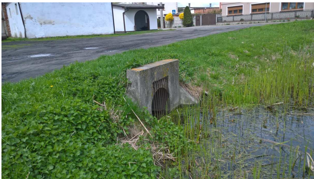
Fot. 3. Budowla spustowa z ciągu zbiorników wodnych – stan dobry – odpływ zapewniony
