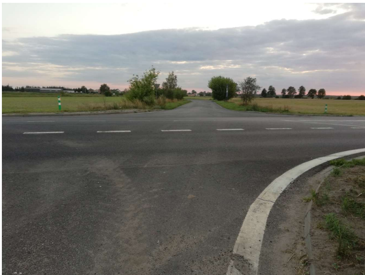
Widok na skrzyżowanie i drogę gminna nr 810644P
