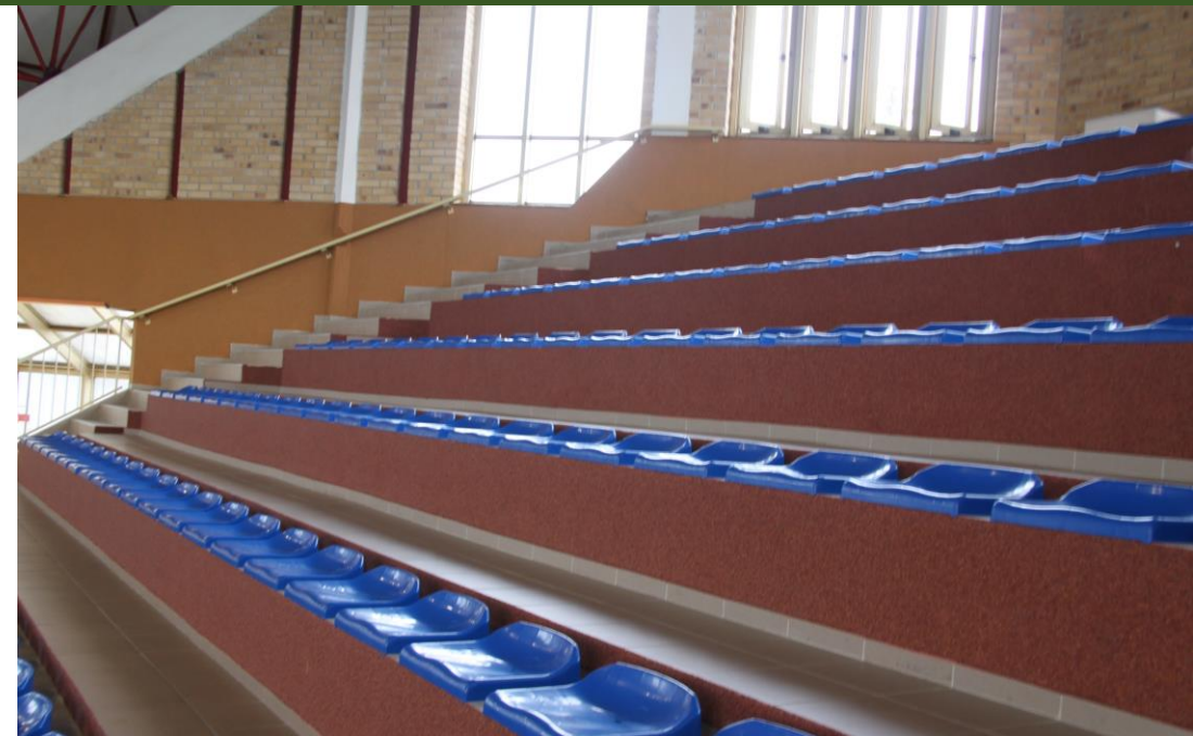
REMONT DRUGIEJ TRYBUNY NA KRYTEJ PŁYWALNI
