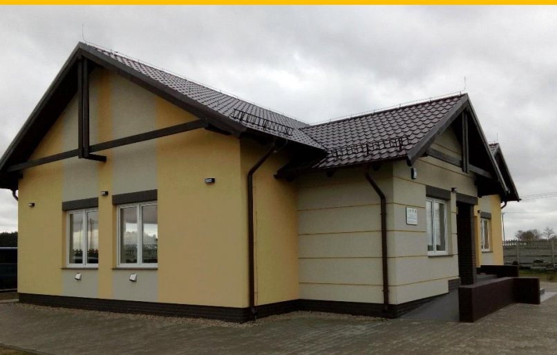
Budowa świetlicy wiejskiej w Sarnówce
