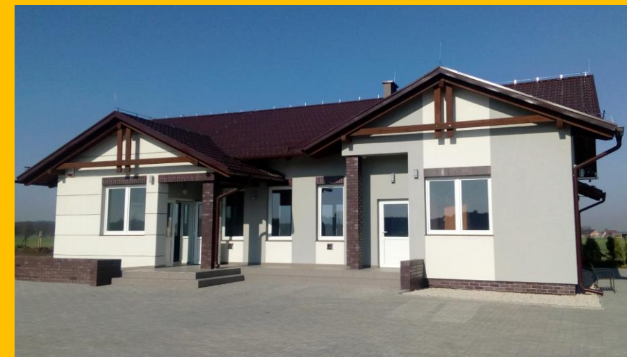
Budowa świetlicy wiejskiej w Łąckiej
