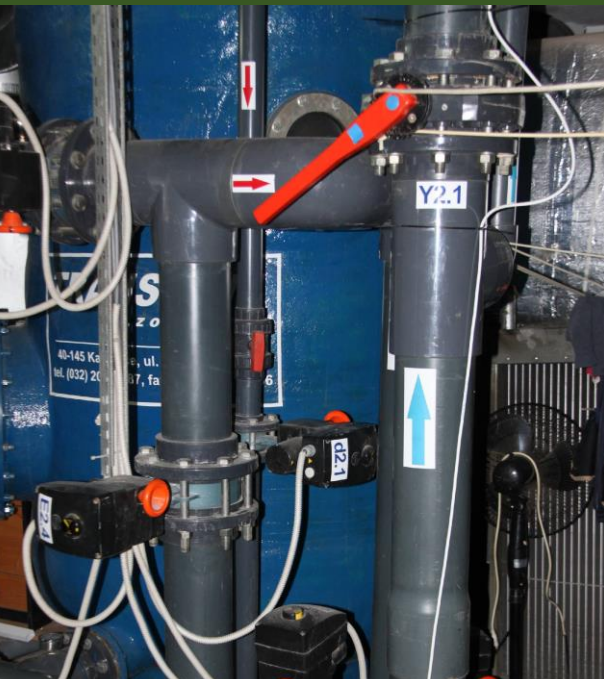
REMONT INSTALACJI WODY WRAZ ZE STACJĄ UZDATNIANIA WODY NA KRYTEJ PŁYWALNI
