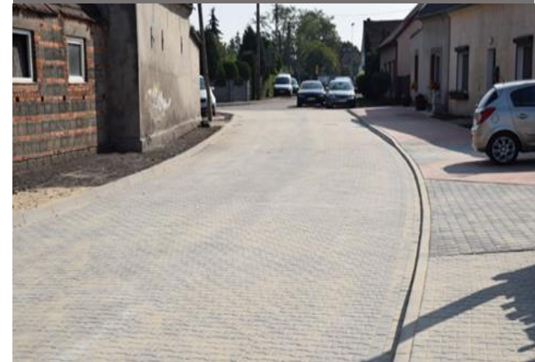
Droga gminna w Żylicach
