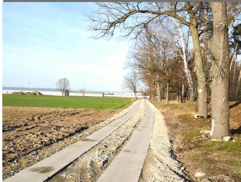
Utwardzenie drogi gminnej na odcinku Słupia Kapitulna - Ugoda
