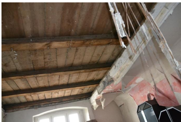
Zerwany sufit ze stropu na poddaszu.
