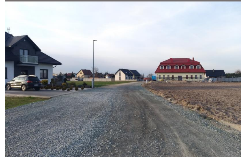
Utwardzenie drogi gminnej w Zielonej Wsi
