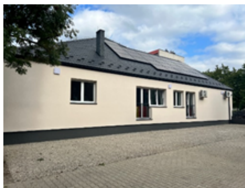
Budynek SPZOZ po termomodernizacji
