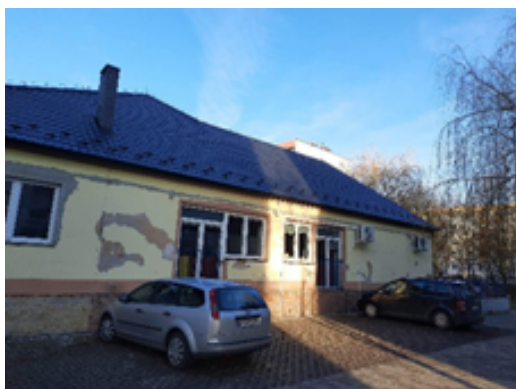
Budynek SPZOZ przed termomodernizacją
