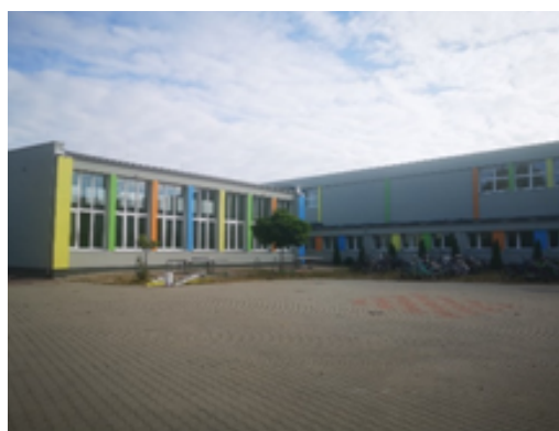
Budynek SP4 po termomodernizacji
